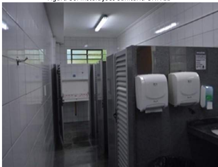
Figura 86. Instalações Sanitária UNIVEL
